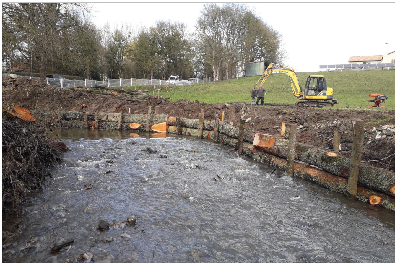
©Cellule Cours d'eau
