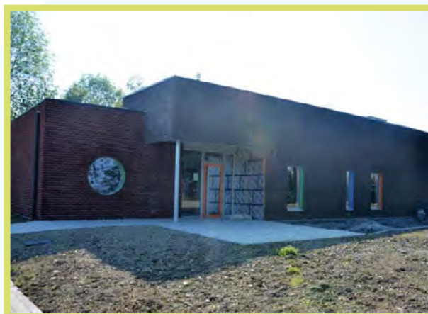
Hôpital de Marche – crèche en construction
